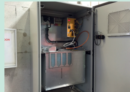
De Pilz veiligheidsbesturing verwerkt de gegevens van SafetyEYE
